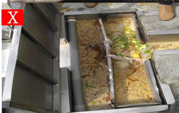
圖 3-6-9 截油槽設置不良示意圖
